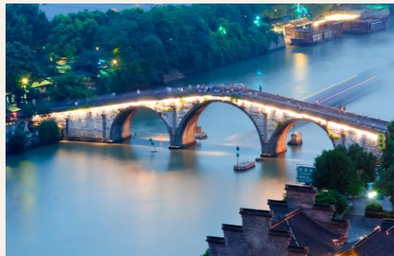
Gongchen Bridge 拱宸桥 1.4km 步行15分钟
